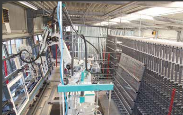
Roboter-gestützte vollautomatische Verglasung für hohe Präzision und Fertigungsqualität
